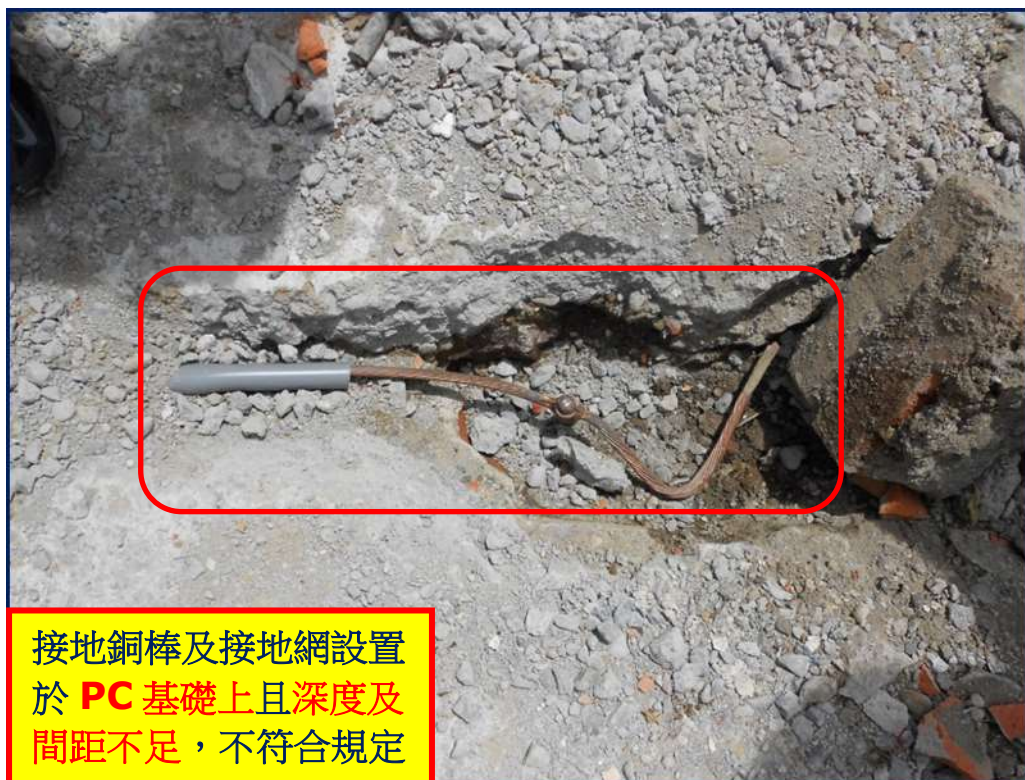
接地系統施工 缺失 照片
